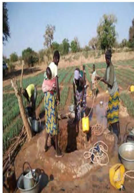
Poço não protegido
