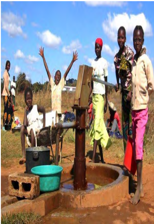
Furo protegido com bomba manual
